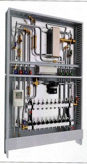
Die Kombi-Station Taco-Therm Dual von Taconova ist für die dezentrale Durchfluss-Trinkwassererwärmung und die Versorgung des Heizsystems konzipiert. Für Sicherheit und höchsten Komfort bei der Erst- und Nachbefüllung von Heizungsanlagen
